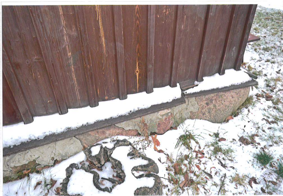
Fot. 4. Fundament i okapnik, fot. P. Szczurek, 2021.
